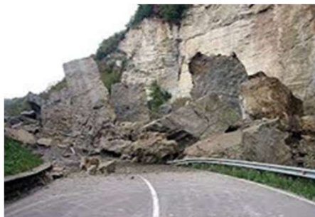
Protezione Viabilità Stradale
