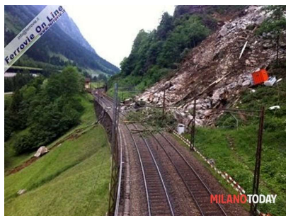
Protezione Viabilità Ferroviaria
